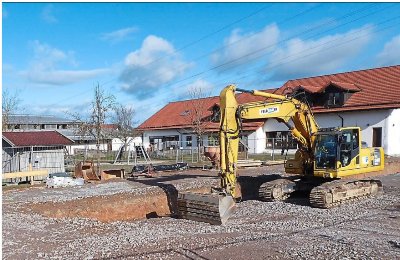
Auf der Baustelle des Kinderhauses Zandt laufen die vorbereitenden Arbeiten.
