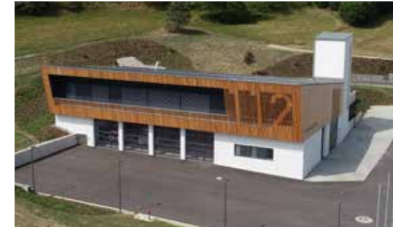
FF Haus der Feuerwehr Zandt, Einweihung am 25. August 2019
