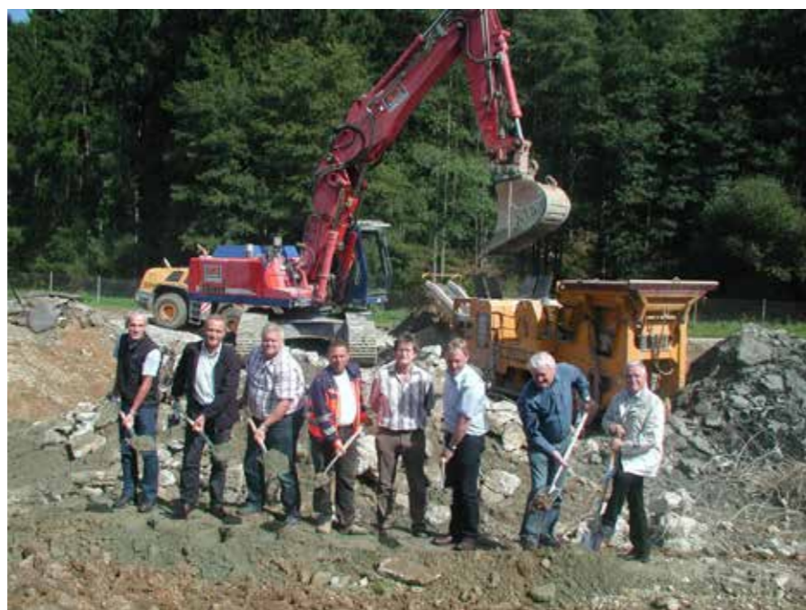
Spatenstich Kläranlage September 2012
