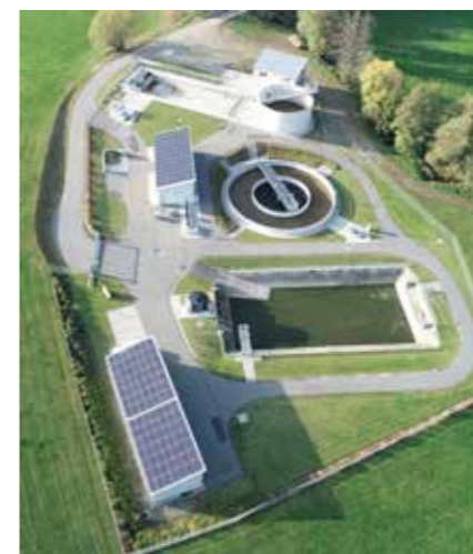
Kläranlage am Pfahl 13, Einweihung am 2. August 2014
